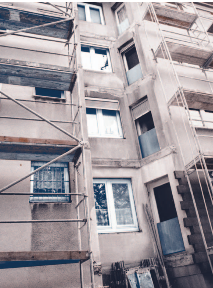
Nach und nach werden weitere Liegenschaften umfangreich saniert und modernisiert.
