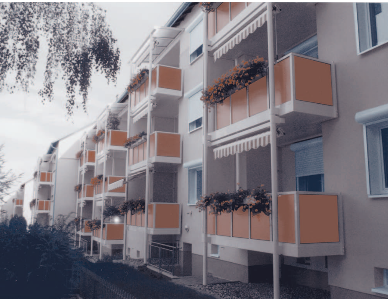
Unsere Häuser in der Georg-Treser-Straße in Frankfurt-Oberrad nach Abschluss der Großsanierungsmaßnahmen.
