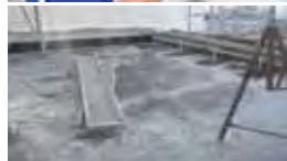
> Rohbau mit 432,1 T€,
